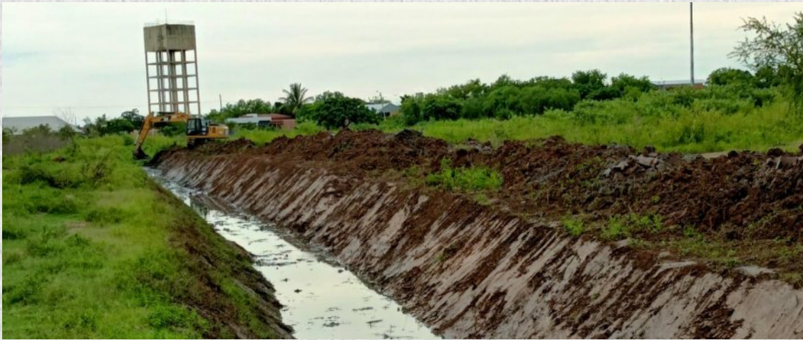
LIMPIEZA EN CANALES DE DRENAJE
