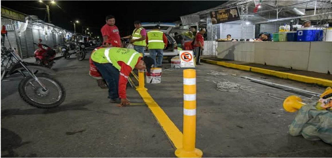
Pintado y señalización av. Barrientos
