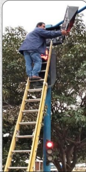
Mantenimiento preventivo y correctivo de semáforos e implementación de contadores regresivos en diferentes intersecciones de calles.
