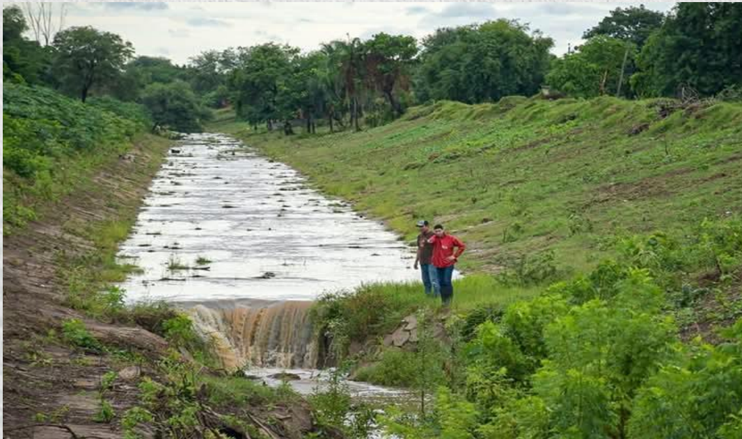
Limpieza de Canal Muyurina.
